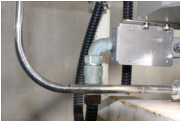
(写真④：溶接継手現地配管採用部位の写真)
